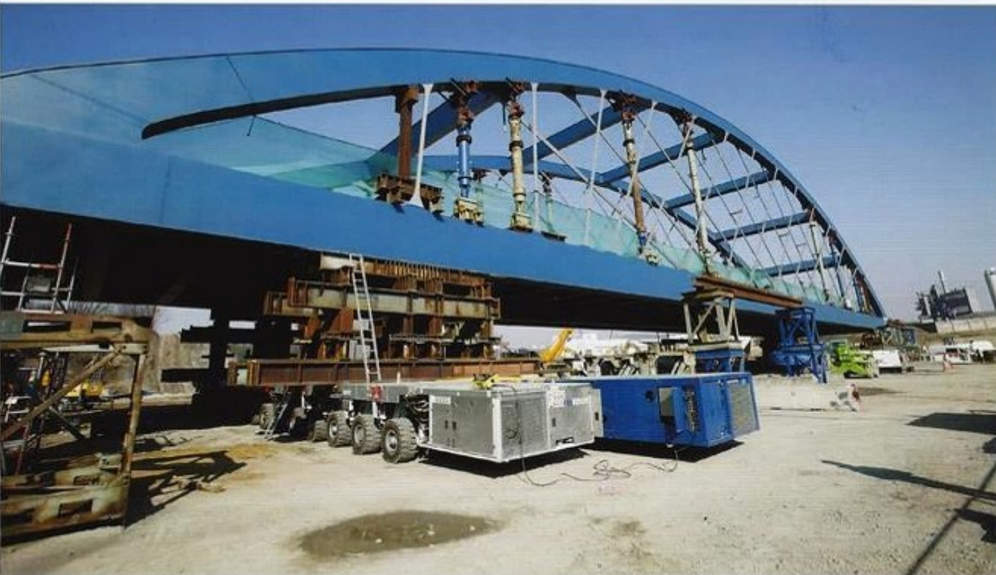
Die hydraulisch gesteuerten Schwerlasttransportelemente ermöglichen den millimetergenauen Einbau der Brücke.
